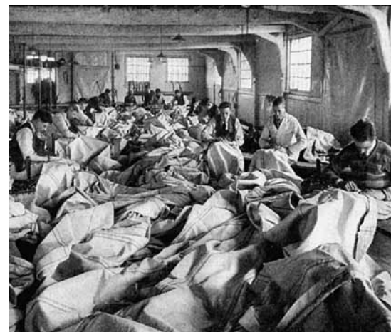
Zusammennähen eines Großsegels, Foto aus dem Buch „Das Segel“ anno 1937
